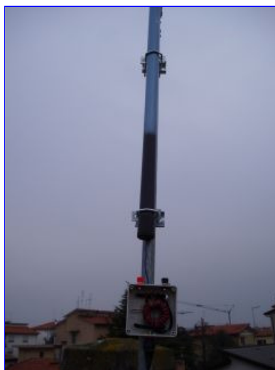
Foto 6 (Fissaggio al palo)
