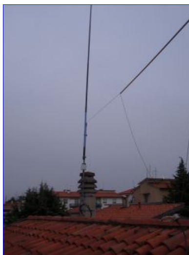
Foto 8 (Primo piano a lavoro ultimato)
