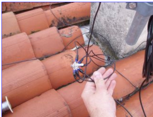
Foto 7 (Fissaggio dei radiali)
